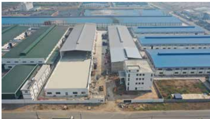
Công trình Nhà xưởng H6
