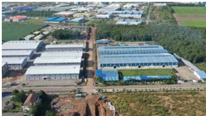
Công trình Hạ tầng đường số 6 - KCN VH2
