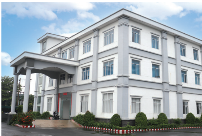
Xây dựng công trình công nghiệp & dân dụng
