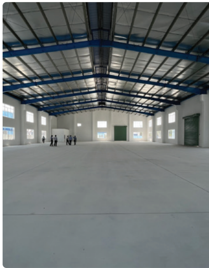
Nhà xưởng xây sẵn cho thuê
