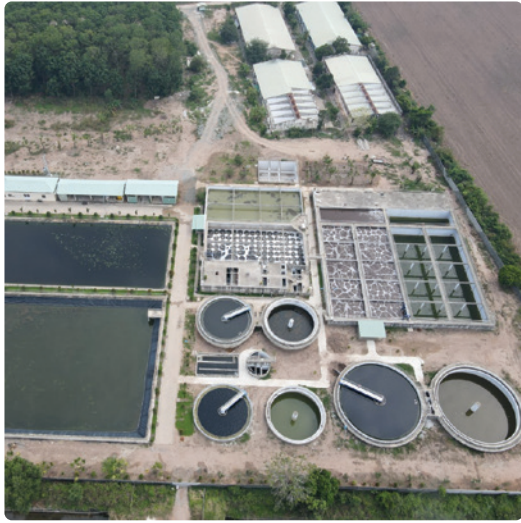
Nhà máy xử lý nước thải
